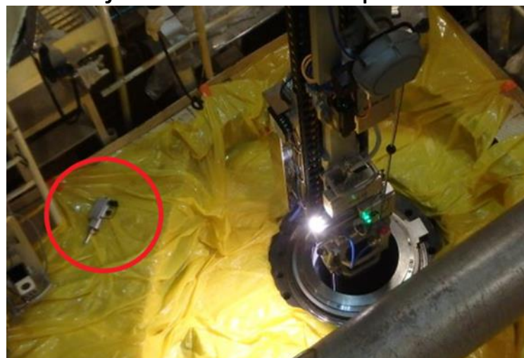
Předmět položený na plošině nad primárním kolektorem PG.
