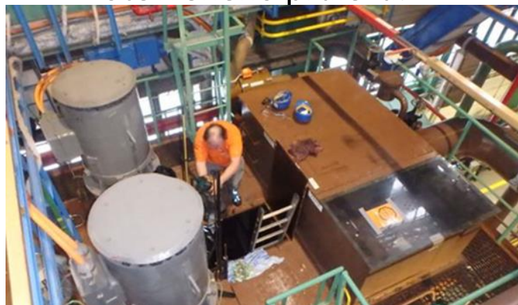
Předměty na hlavní olejové nádrži turbogenerátoru blízko otevřeného průlezu.
